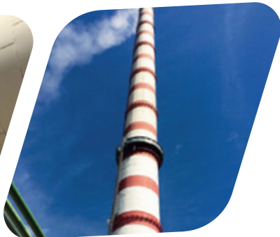
На дымовой трубе
